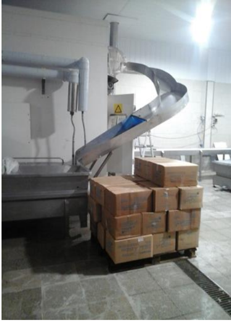
Ilustración 3 Rampa para deslizamiento pescado
