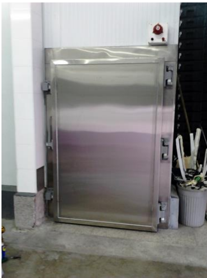
Ilustración 2 Puerta de cámara
